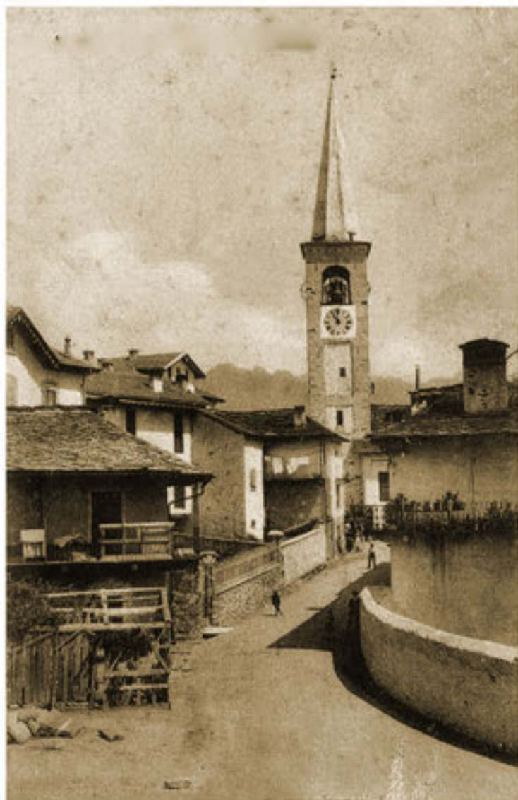
Casale via XX Settembre anno presunto 1920-30 oggi via Marconi
